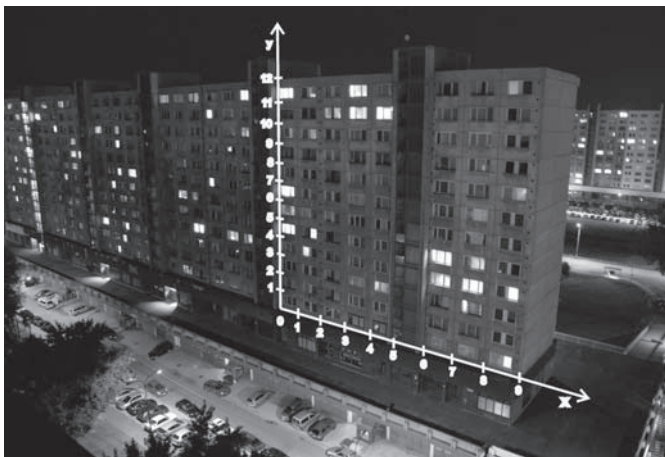
• obrázok 11 Bytový dom č. 2, pohľad zhora
